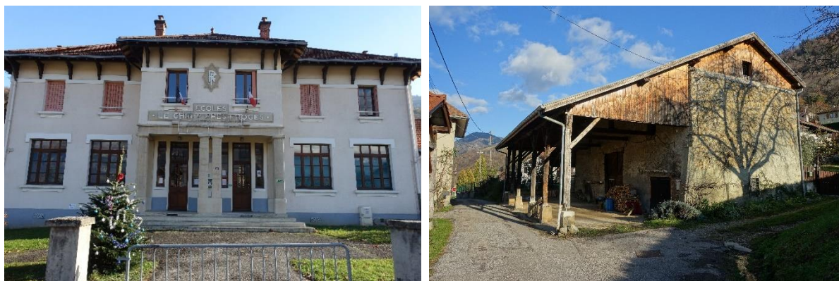
L'école de Champ Près Froges et les constructions « agricoles » à l'architecture rurale (charpente en chêne et châtaignier, abri pour déposer les récoltes et quelques outils).
