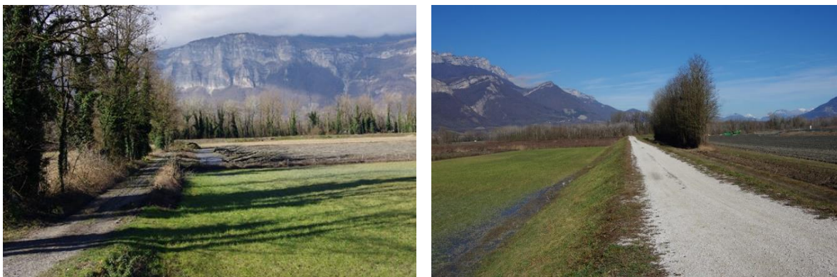
Figure 20 L'Isère derrière la ripisylve en fond de plan (à gauche) et la digue aménagée en voie verte (à droite)
