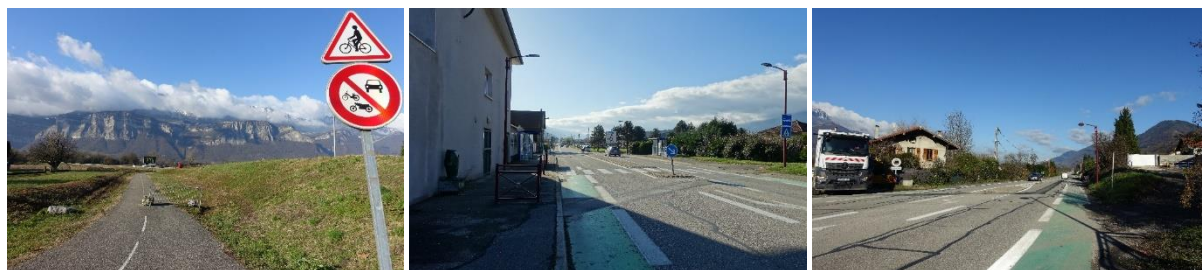
Aménagements cyclables en site propre et sur voirie le long de la RD10A et de la RD523
