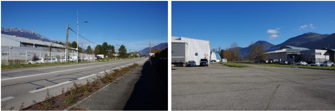
Figure 27 La ZA, vue de la D523 (à gauche) et les bâtiments de la ZA (à droite)
